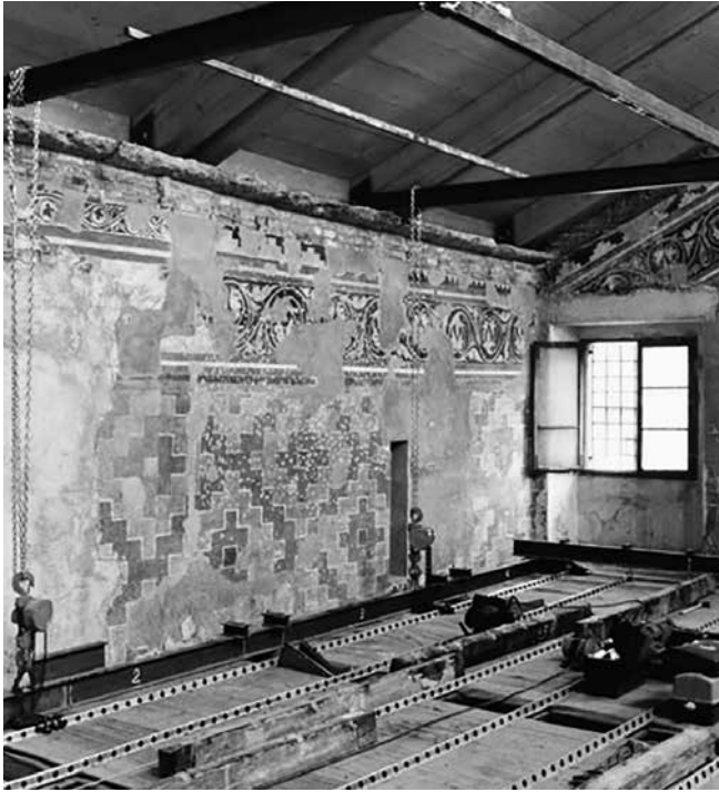
Palazzo Emilei Forti, ora Museo Amo, le decorazioni trecentesche emerse negli anni '80 durante il cantiere
