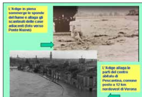
Figura 15. Livello molto pericoloso dell'Adige in città, testimonianza di allagamenti degli scantinati (foto in alto) e parziali allagamenti a Pescantina (in basso).
