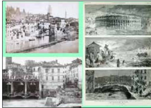
Figura 13. Foto e ricostruzioni dei danni prodotti al centro storico di Verona nei punti di rottura degli argini.
