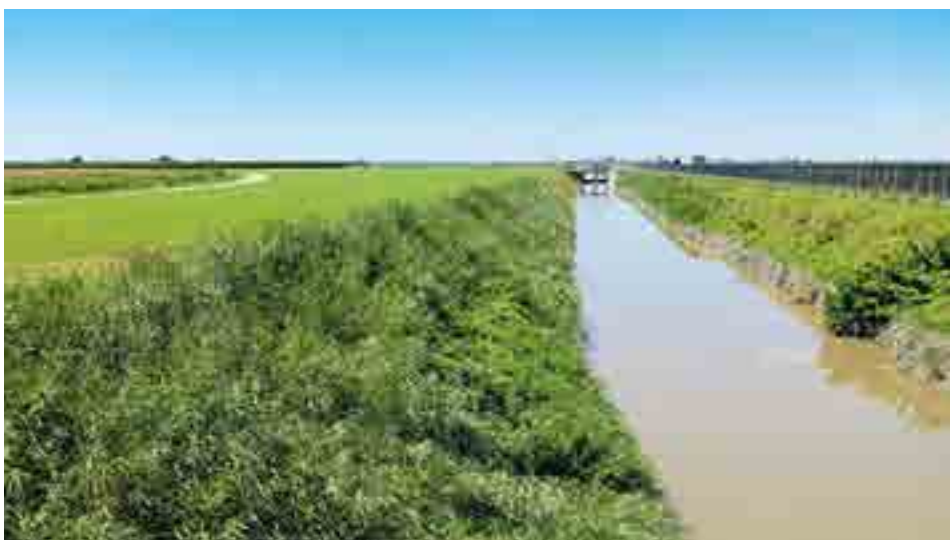
Canale di drenaggio realizzato nel corso delle opere di bonifica.
